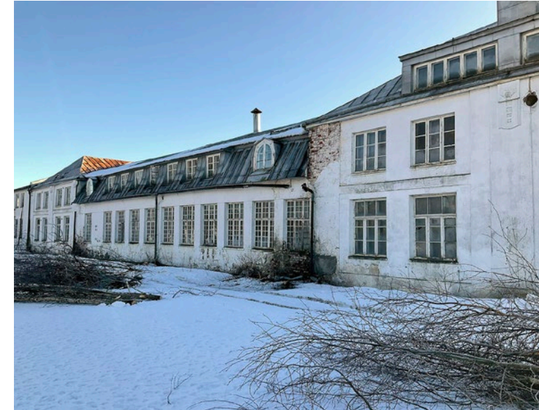
Joen puoleinen julkisivu nykytilassaan. Keskiosan alakerrassa on ikkunoita eri määrä kuin vuoden 1921 julkisivupiirustuksessa
