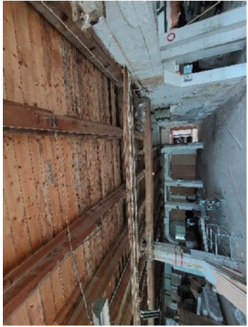
Palkeissa taipumaa, betonisessa välipohjassa halkeamia
