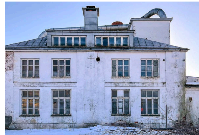
Katon suorakulmaiset ikkunat poikkeavat alkuperäisen julkisivupiirustuksen mukaisesta ikkunasta
